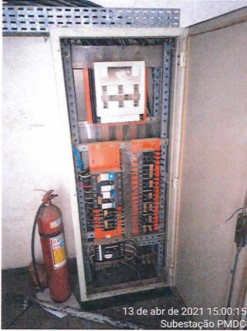
Figura 3 – Quadro de Distribuição.
