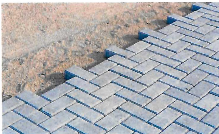
Figura 1: Assentamento de piso intertravado.
