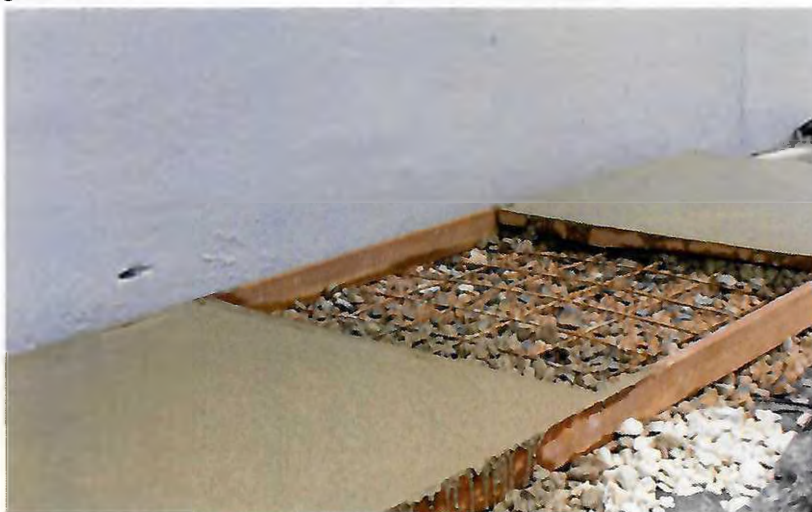
Figura 2: Concretagem da calçada.
