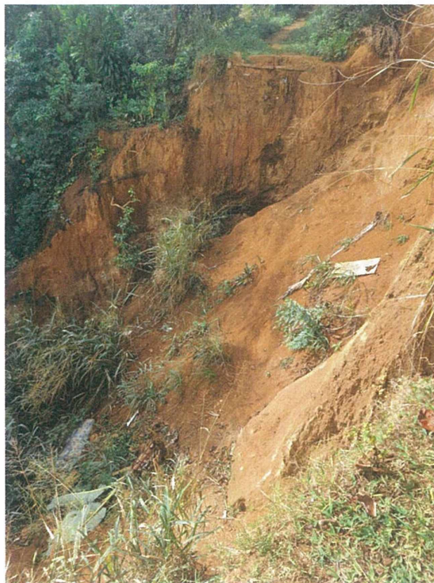
Figura 01: Crista do talude (Rua Doze) Fonte da Imagem: Autor
