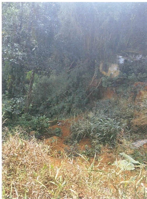
Figura 02: Vista da Base do Talude Fonte da Imagem: Autor
